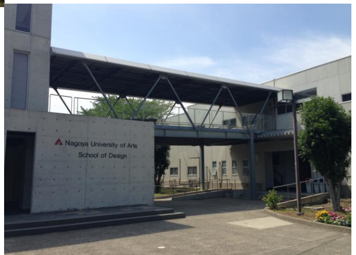
※4 平成16年度 西X・G棟渡り廊下増築（バリアフリー）
