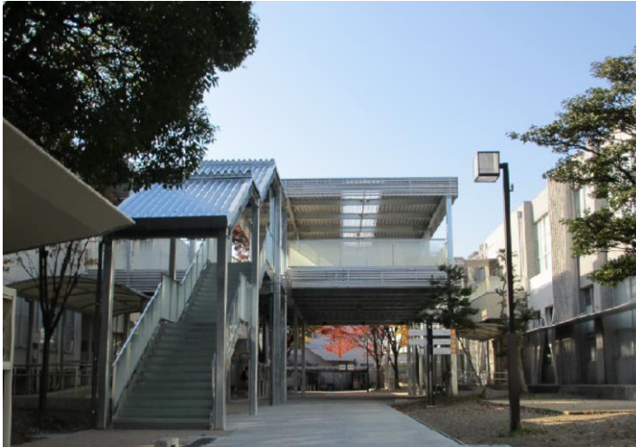
※1 平成24年度 西B・G棟渡り廊下増築（バリアフリー）
