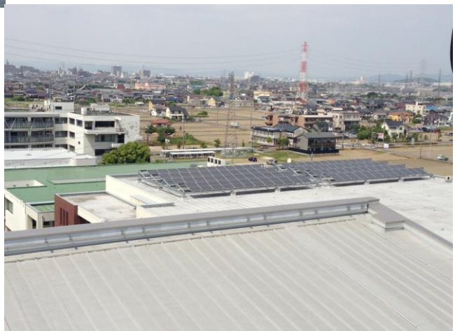
※7 平成22年度 西体育館屋上太陽光発電設備設置(40kw)
