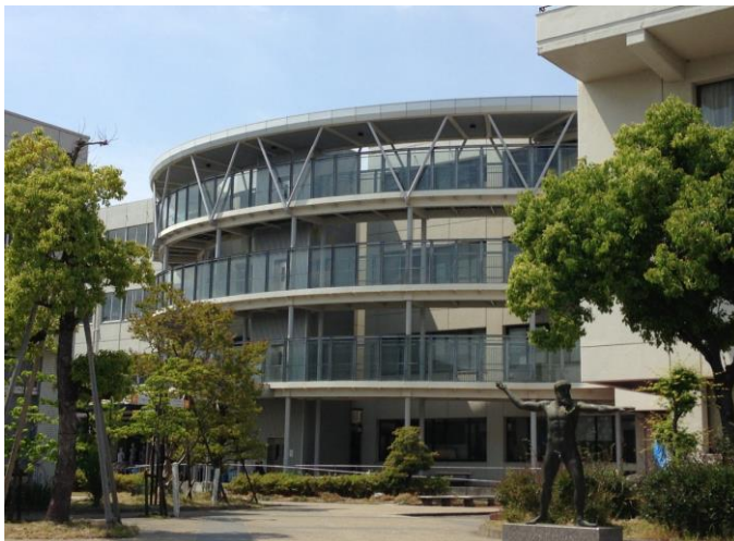
※3 平成17年度 西H・K棟エレベーター渡り廊下増築（バリアフリー）
