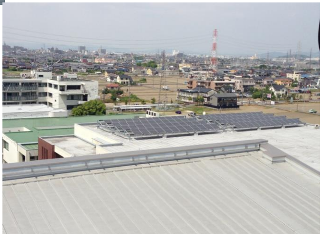
※13 平成22年度 西体育館屋上太陽光発電設備設置(40kw)
