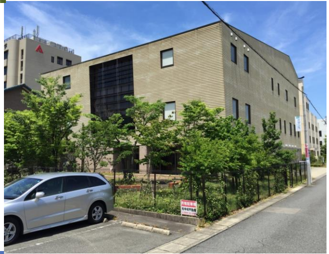
※1 平成27年度 校舎・園舎の硝子飛散防止フィルム施工 (非構造部材耐震)東キャンパス2号館
