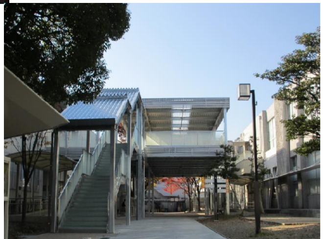
※6 平成24年度 西B・G棟渡り廊下増築 (バリアフリー)
