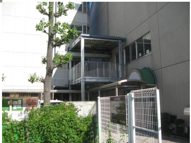
※2 平成27年度 本館・清雅館渡り廊下新設(バリアフリー)
