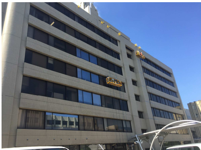
※1 平成31年度 東1号館北面・西面外壁タイル浮き注入工事
