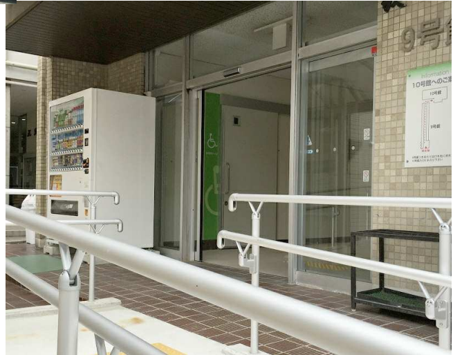
※5 平成26年度 東キャンパス 玄関自動ドア・スロープ・ 手摺・多目的トイレ改修(バリアフリー)
