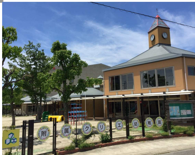
※3 平成27年度 校舎・園舎の硝子飛散防止フィルム施工 (非構造部材耐震) クリエ園舎
