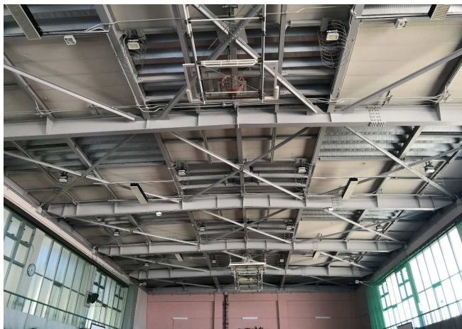
※2 平成31年度 東キャンパス3号館・8号館LED照明更新工事
