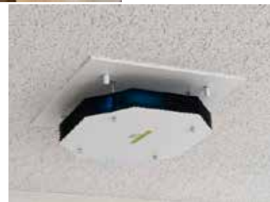
天井に設置された「紫外線空気殺菌機」
